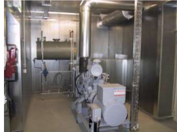
Netzersatzanlage
